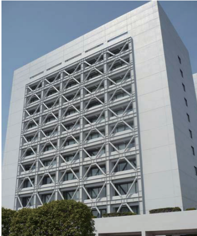
写真2 外付け補強への適用例 Photo 2 Out-plane reinforcing
